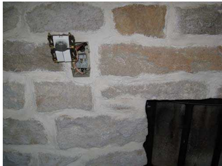
Le thermostat et la commande du ventilateur : marche/arrêt, auto/forcé et réglage vitesse. Le réglage du thermostat (40°C) est au fond de la boîte d'encastrement)
